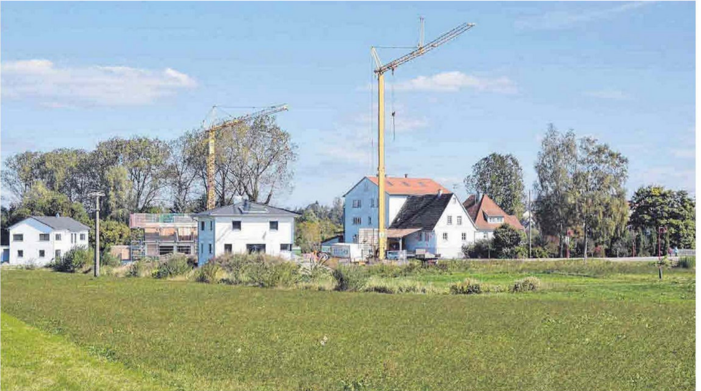
Nicht alle Bremer finden die neuen Bauplätze im Baugebiet Bremer Mühle attraktiv.
