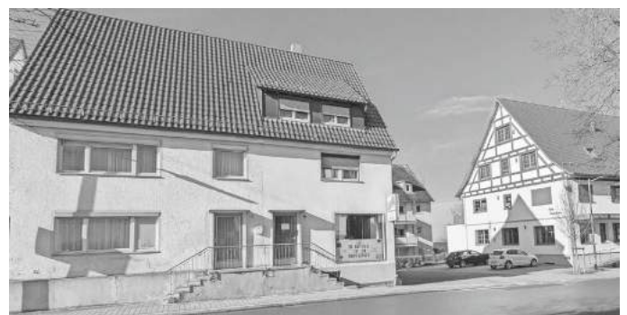
Links: Haus Koch, die frühere erste Schule der Göge, rechts: Das frühere „Amtshaus“, saniert von K.-J. Stehle.
