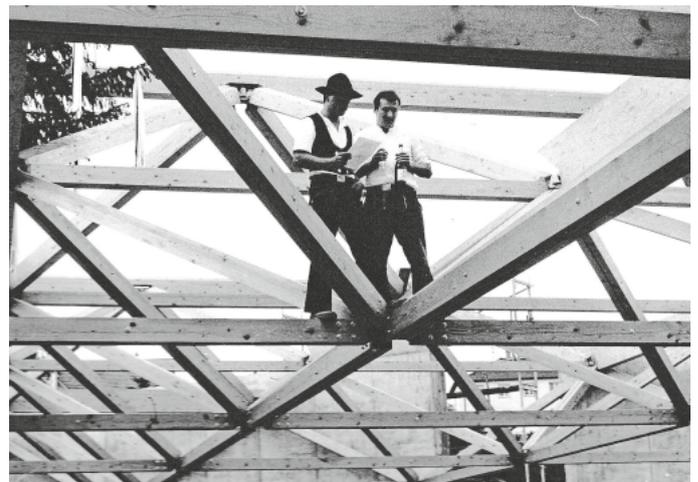
Zuvor wurde in einer spektakulären Aktion die **gesamte Dachkonstruktion**, die vorher **am Boden zusammengebaut** worden war, von drei Autokranen in die endgültige Lage gehoben.
